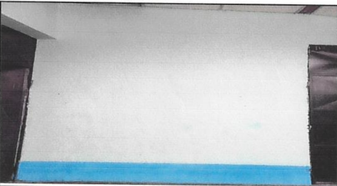
Foto 3: Pintura en muros, cocina, aula, direccion y baños exteriores e interiores
