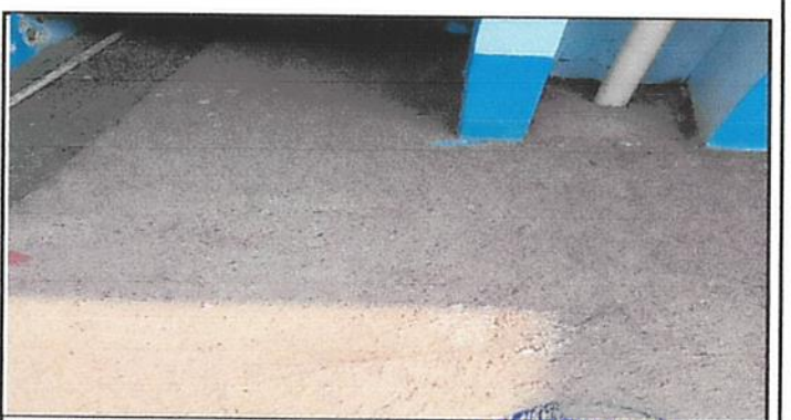
Foto 6: Sustitución de piso de granito
